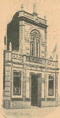
Fachada do escritório
