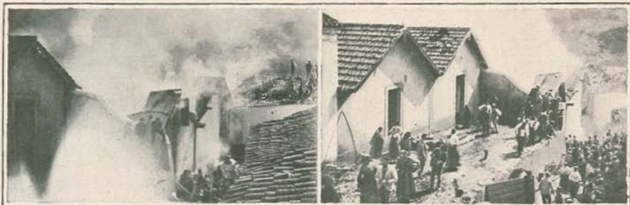
1. Castelo de Vide: Aspéto do incendio da rua dos Loureiros.—2. Outro aspéto do incendio. A' esquerda os barracões das officinas dos cegos vendo se a arder os barracões que ficaram totalmente destruidos. Ao fundo a cocheira de José Leitão que a custo se salvou.—(Clichés do distinto amador sr. M. Santos Soares.)
