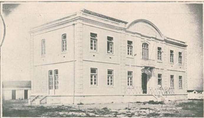
Hospital de Salvaterra de Magos, para cuja construção contribuiu principalmente com o seu dinheiro e os seus inteligentes esforços o abastado proprietario sr. Gaspar da Costa Ramalho.—(Cliché do distinto photographo amator sr. Alvaro Barbosa)
