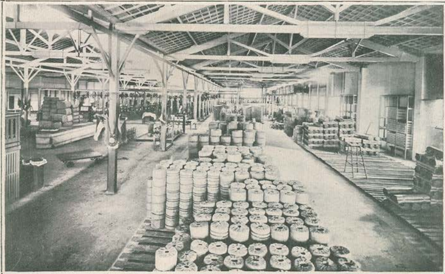
1. Fachada do edificio na Travessa Rui Barbosa.—2. Sr. Antonio Gonçalves Martins, atual socio gerente da fabrica. 3.—Deposito de cabos e amiagem.
