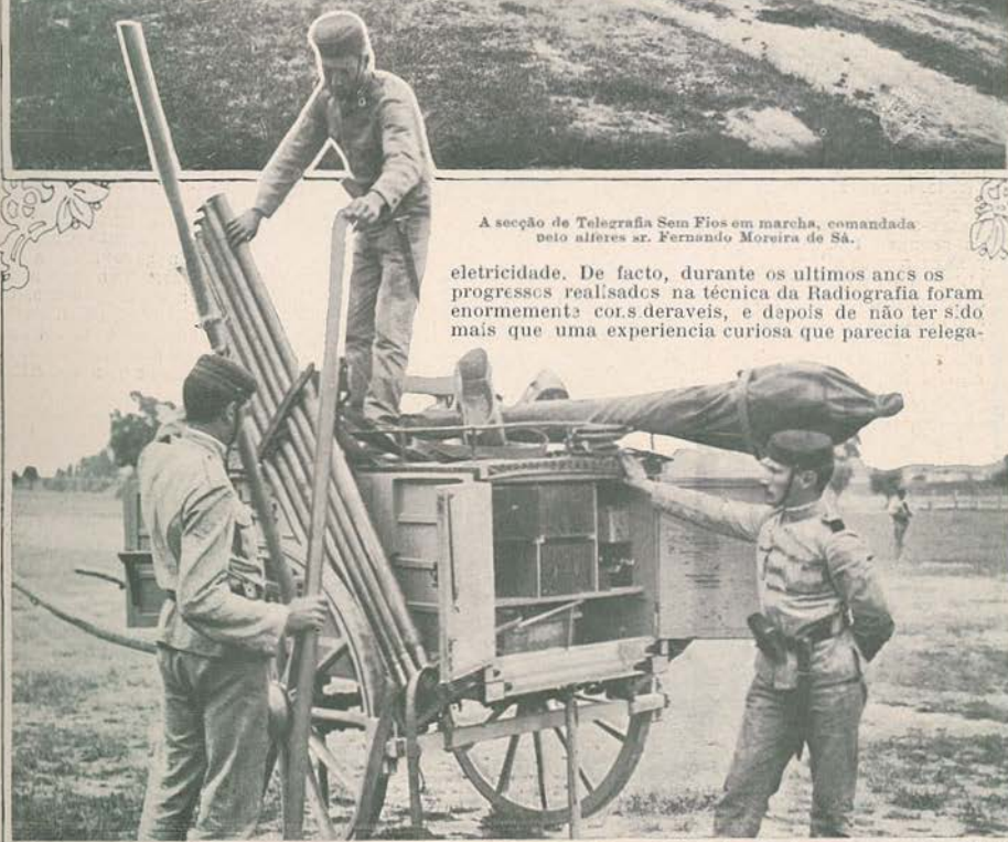
Um aspecto do carro do material durante a descarga dos tubos
