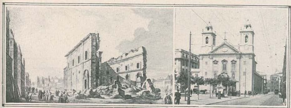
Ruínas da igreja de S. Paulo junto da Moeda, onde as sentinelas ficaram guardando o dinheiro enquanto os muros altavam.—4. A actual igreja de S. Paulo no mesmo local.
