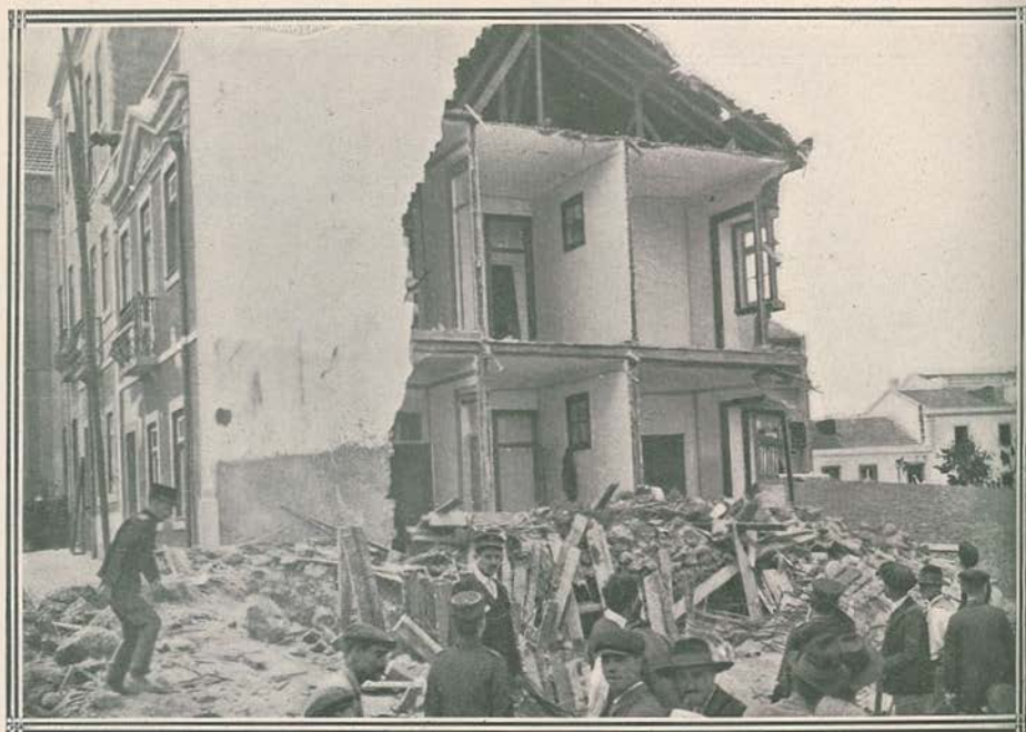
Um aspecto das casas desmoronadas no Alto do Pina em virtude dos maus materiais empregados na sua construção e em cujos escombros ficaram três homens mortos.
