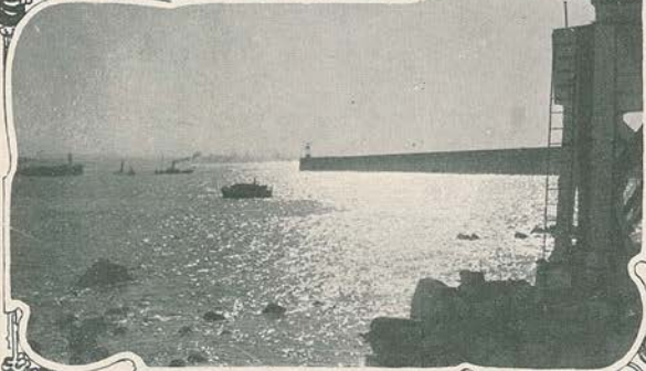
1—Um bloco de 30 toneladas atrado ao mar por um dos grandes guindastes do porto de Leixões
