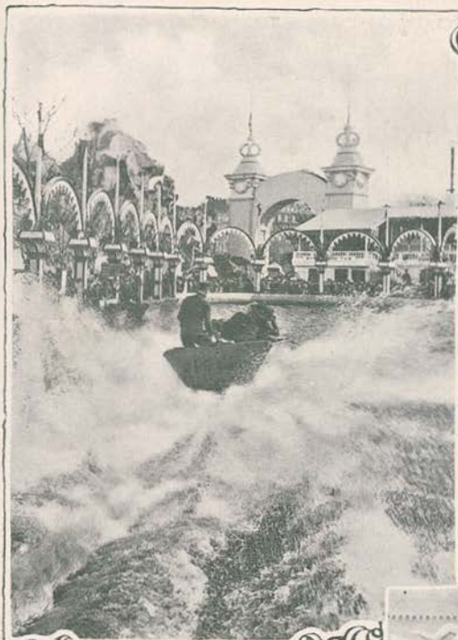
1—A entrada no lago de um barco do "Water Chute."
