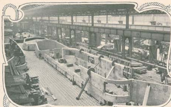
A montagem das chapas blindadas do couraçado brasileiro «Minas Geraes».
