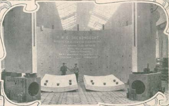
4—Couroças de 12 polegadas construído nas officinas Armstrong para o couraçado «Dreadnought»
