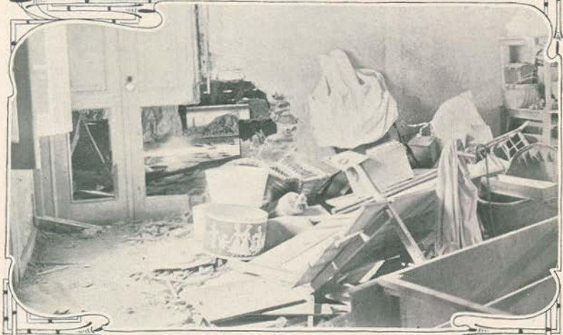
2—Um dos quartos das credas do palacio da rua Marquez de Fronteira onde uma granada perfurou a parede
