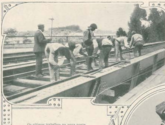
Os últimos trabalhos na nova ponte
