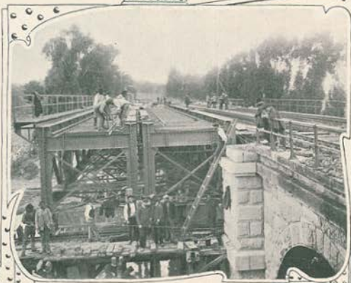
A nova e a antiga ponte lado a lado antes do deslocamento
