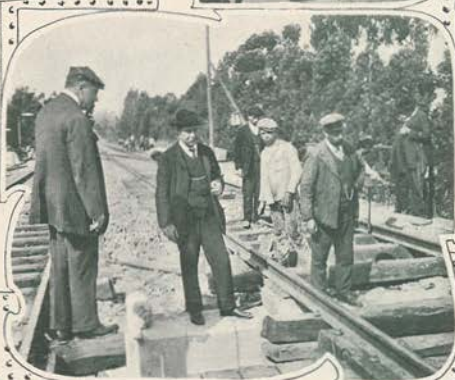
O engenheiro sr. Greenfield de Mello dirigindo os trabalhos de ligacao da nova ponte
