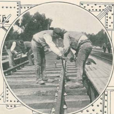
O aparelhamento dos rails na nova ponte
