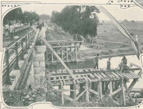
A velha ponte antes de deslocada
