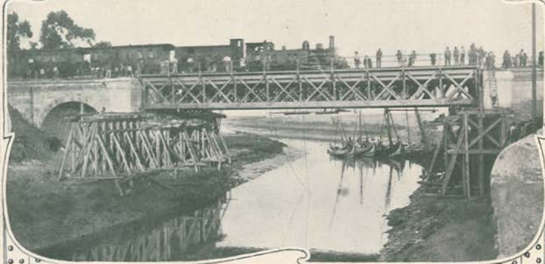
A passagem do primeiro comboio sobre a nova ponte
