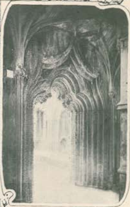
Corredor de entrada das capellas imperfeitas
