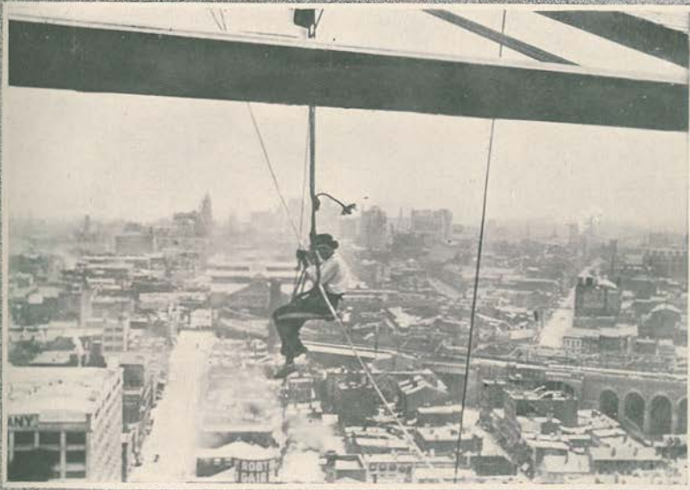
A collocação de uma trave de ferro a 200 metros sobre o solo. Um operario suspenso sobre Nova-York. (Cliches de DELIUS)
