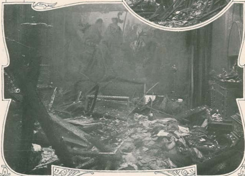
1—A sala de bilhar depois do incendio. 2—Uma das paredes da sumptuosa sala de musica. 3—O salão vermelho ou sala dos Arrazes, depois do incendio.
