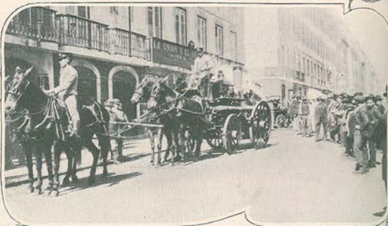
1—A segunda galeria onde existe a chupadeira (desenho sobre croquis do sr. E. Roscira) 2—A bomba na rua da Prata
