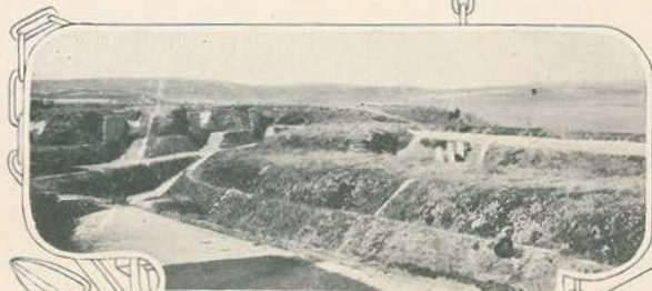
Diversos aspectos das baterias da barra de Lisboa
