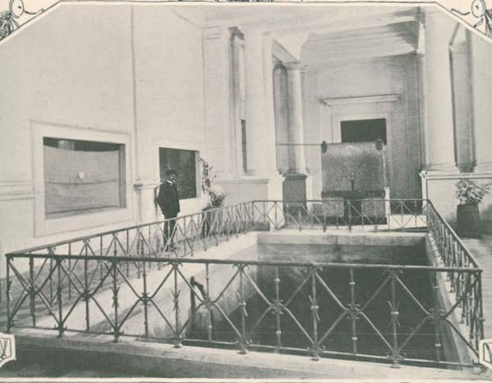
1—A fachada do edificio, que defronta com a Alameda de Algés 2—O grande tanque da sala de entrada, construído ha mezes —(Clichés de BENOLIEL).
