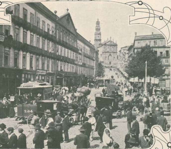
1—Um electrico guilado por soldados de engenharia 2—Aspecto da praça de D. Pedro á chegada dos primeiros carros depois de terminada a grève
