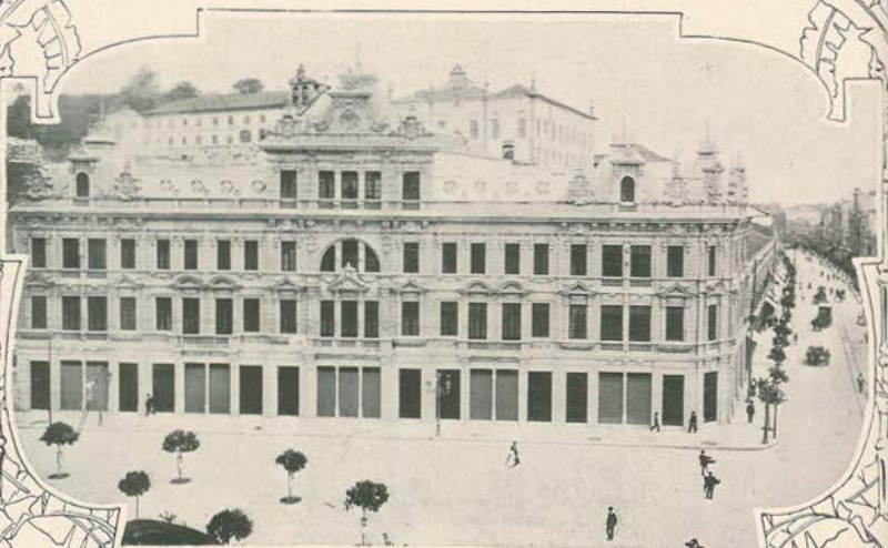
1—Demolição da rua da Carioca para o alargamento 2—Largo e nova rua da Carioca—(clichés de A. MALTA)
