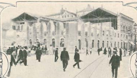
Demolição do Hospital da Ordem Terceira da Penitencia
