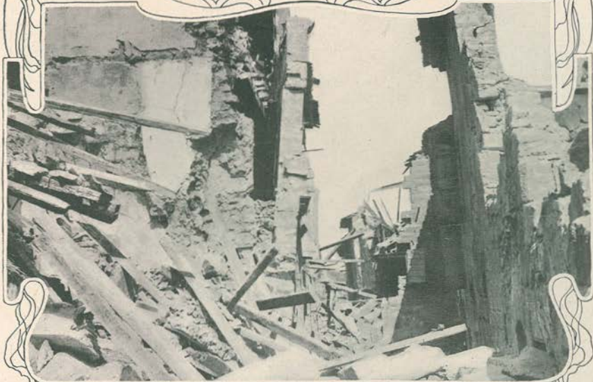
1—Em Saint Conrat: Uma das casas cujo derrocamento produziu maior numero de victimas. 2—Uma rua de Rognes completamente destruida, e na qual se encontraram numerosos cadaveres sob os escombros.—(Clichés de J. THEODORESCO)
