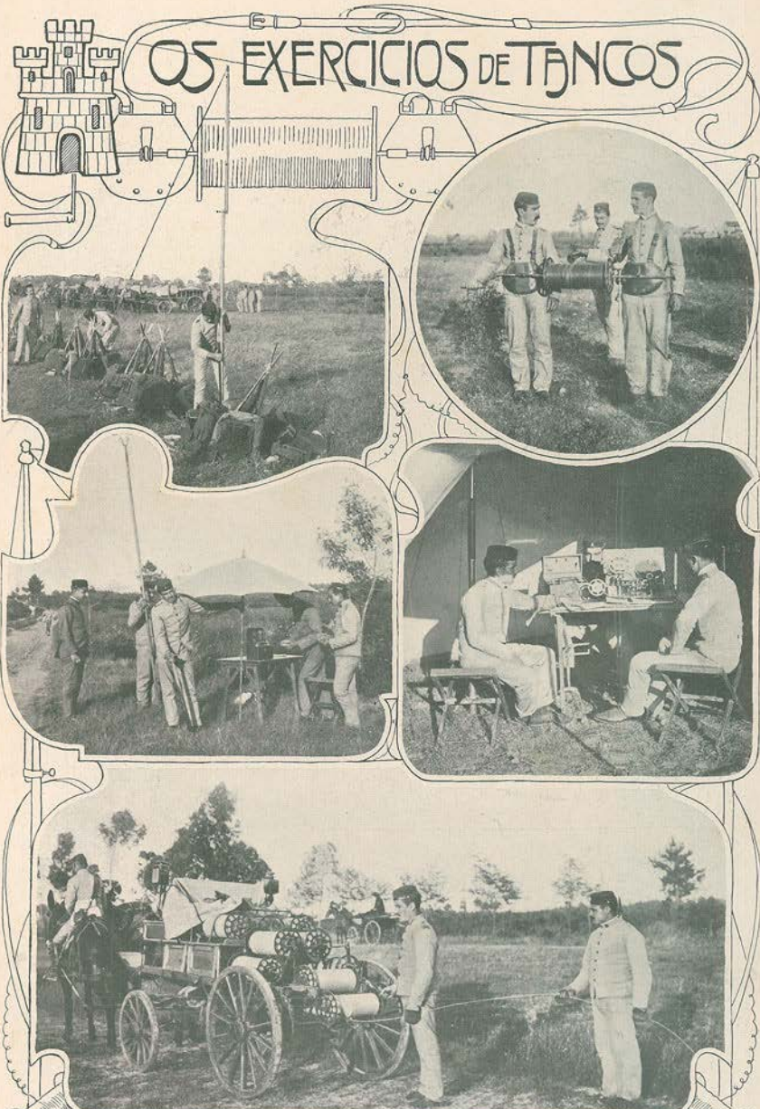
1—Um poste para os fios telegraphicos. 2—Linha telegraphica de campanha: Desenrolando o cabo. 3—Estação telegraphica improvisada. 4— Estação telegraphica de campanha. 5— Na montagem da linha: Ao desenrolar o fio
