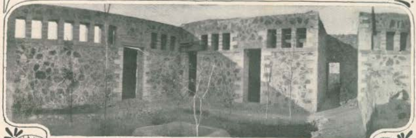
1.—Attitude academica. 2.—Um pedaço dos muros em construção da colonia do Fotodotera, no oiteiro de Kopanas
