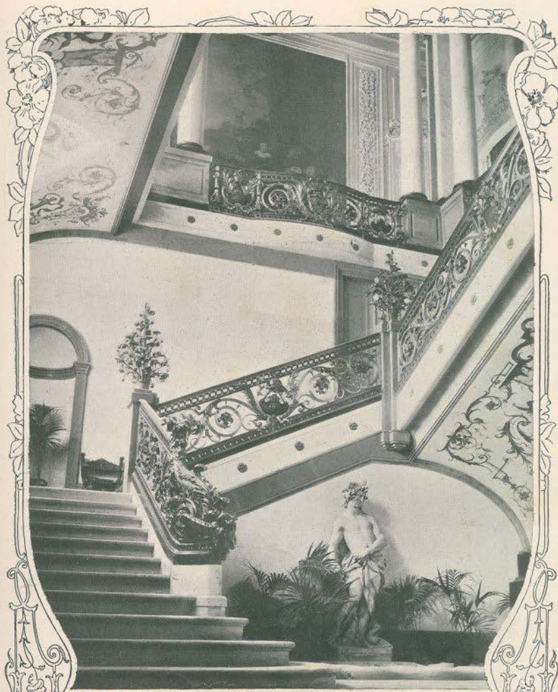
A escadaria monumental do palacio Foz
