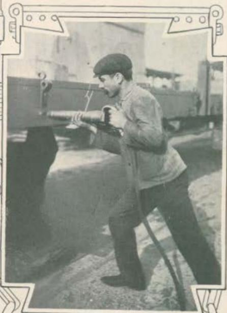
2—Perfuradora de ar comprimido manobrada sem esforço
