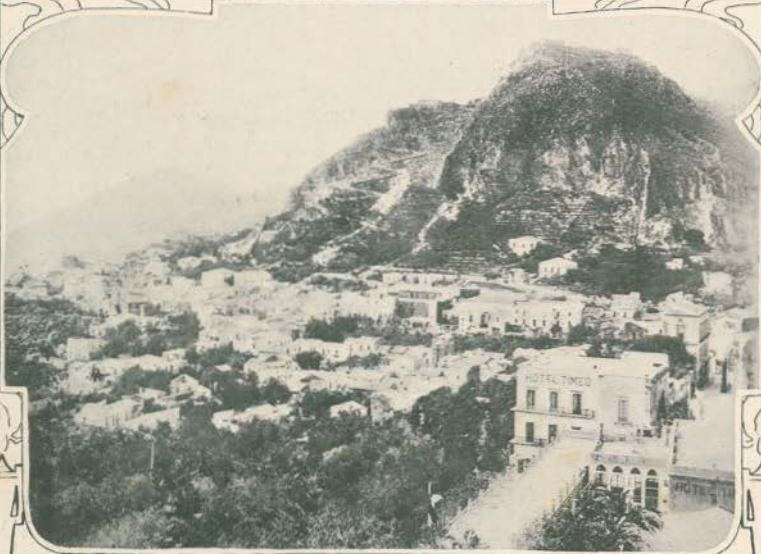
1—Uma fonte nas ruas de Messina 2—Vista geral de Taormina, em grande parte destruída pelo terremoto (CLICHÉS I E CH. DELINS)
