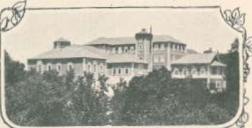
Parque da Estancia das aguas de Entre-os-Rios
