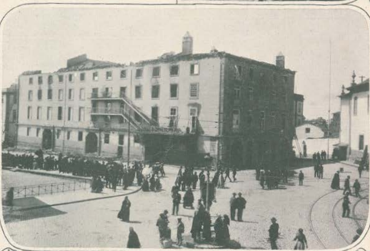
O rescaldo dentro do edificio — Atacando o incendio — Um dos lados do theatro mostrando a escada de ferro exterior
