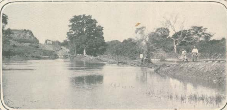
Effeitos das cheias de dezembro de 1906: taboleiro da ponte arrastado pela corrente
