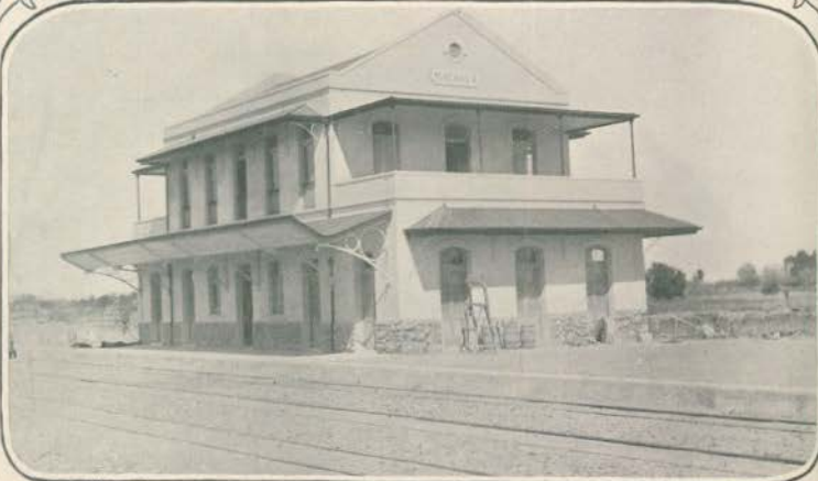
Estação de Machava: Entroncamento do C. F. L. M. com o C. F. S.
