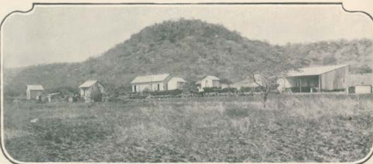
Acampamento da construção na Mailana (junto dos Pequenos Libombos)
