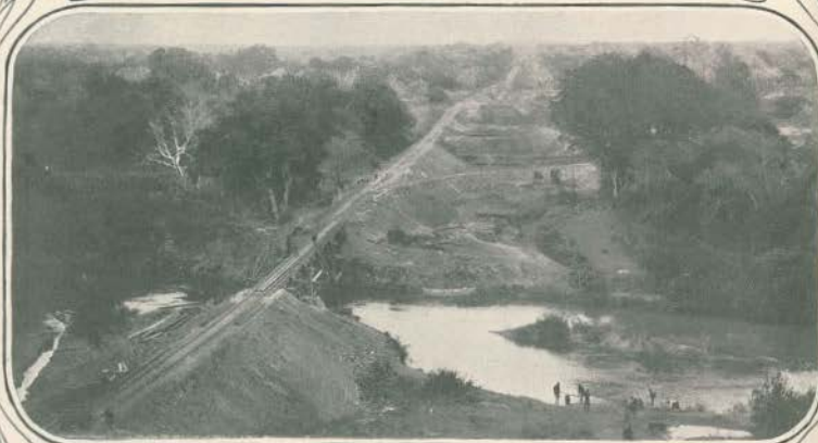
Alinhamento visto do alto de Bohane. Linha d'quem e além do rio Umbeluzi. Ponte provisória. (Vem-se as fundações de alguns pilares da ponte definitiva.)
