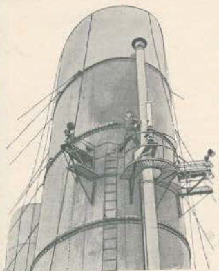
OS CANOS DO «LUSITANIA»—Elevando-se a 48 metros de altura, as chaminés d'este enorme vapor excedem as das maiores fabricas
