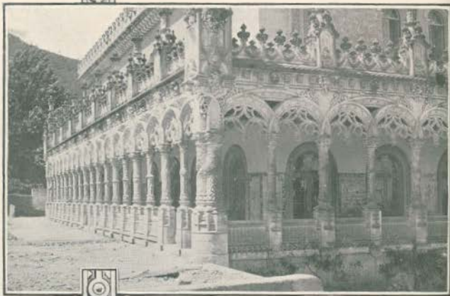
Galeria (vista exterior)
