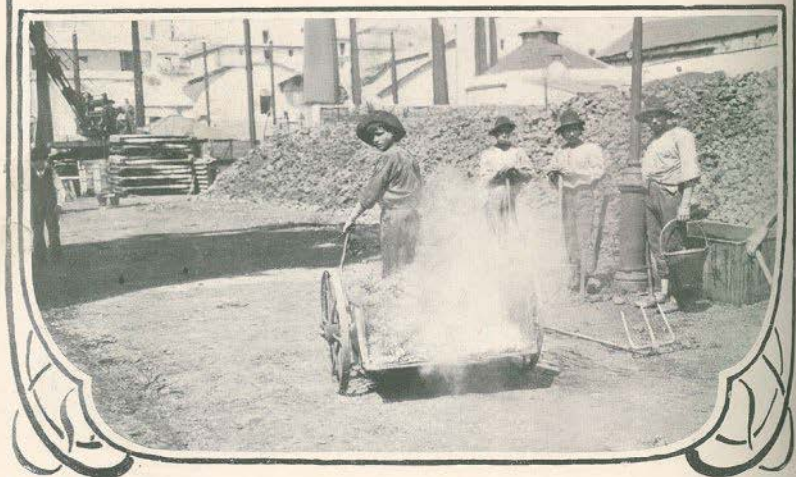
Vista da fabrica — A' volta dos fornos
