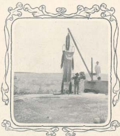
Guindaste com a draga chalut preparada para embarcar, na esplanada do forte de Albarquel
