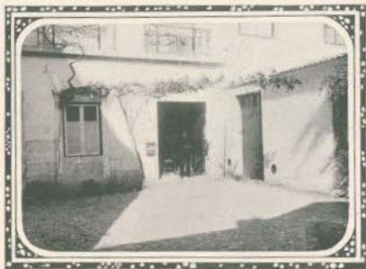
O interior da esquadra do pateo de D. Fradique
