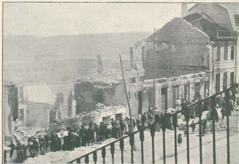
Dois aspectos dos prédios incendiados: Visitas das ruínas, tiradas da praça do Município e da rua António Augusto de Aguiar
