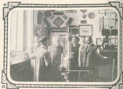
Ensaios de compressão ou esmagamento na machina Ansler-Laffon
