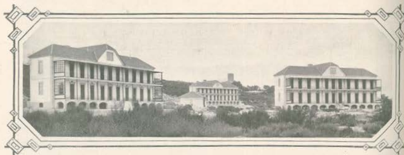
Tres corpos do edificio do Sanatorio
