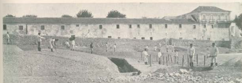
Vista geral das obras
