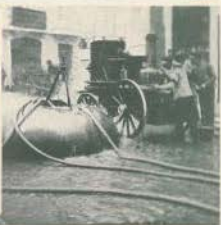
Bomba a vapor do corpo de bombeiros na rua Capello
