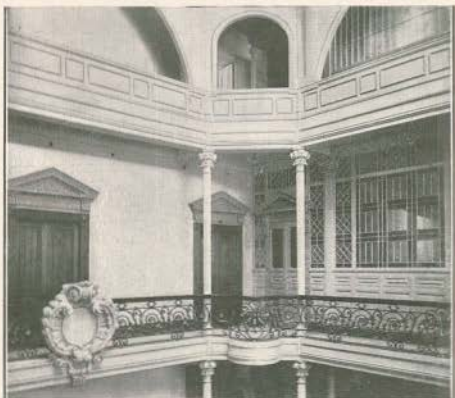
A galeria do 1.º pavimento
