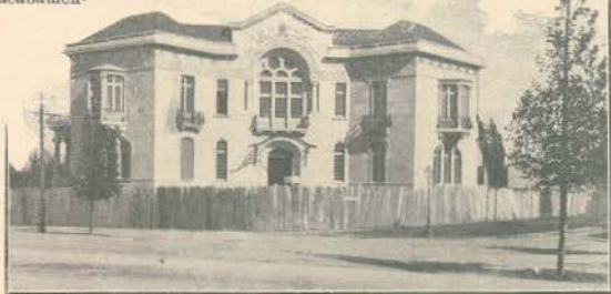
Casa da sr.ª viscondessa de Valmôr, em construção na Avenida Ressauro Garcia [Architecto Ventura Terra]
