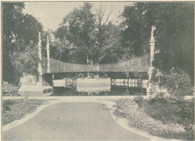
A ponte-pensil mandada construir no parque das Laranjeiras pelo conde de Ffarrobo
