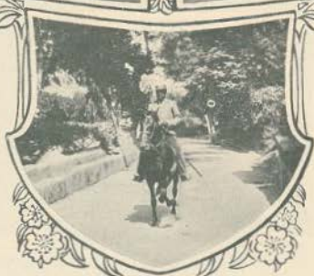
Um aspecto da antiga estrada de Collares
