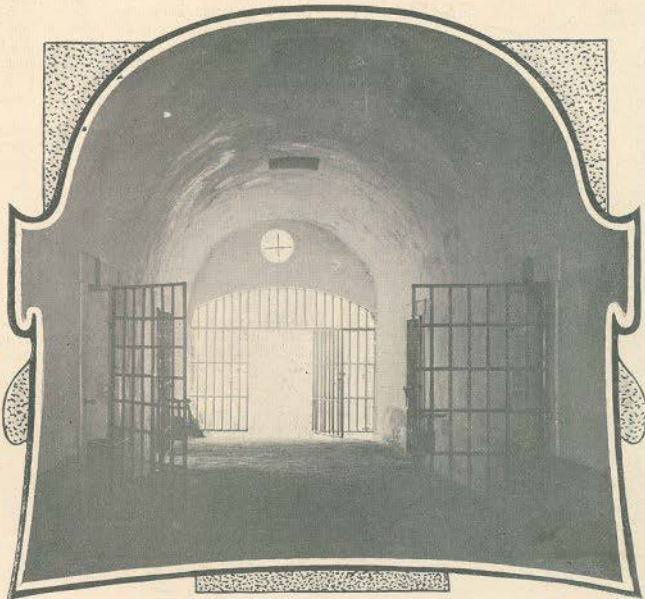
O corredor das prisões subterraneas em S. Julião da Barra
