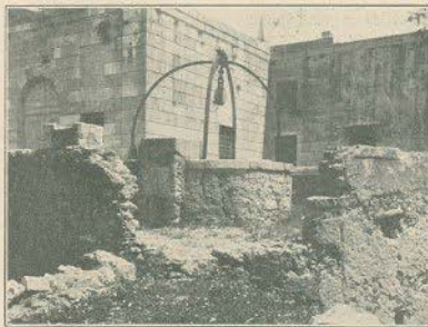
O poço [exterior]
