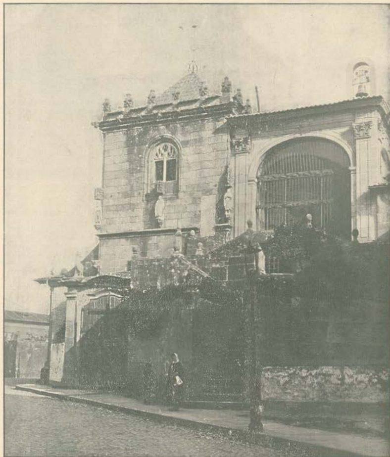
Capella de Nossa Senhora da Conceição: lado sul (CLICHÉ DO EX. mo SR. JOÃO SAN ROMÁN) 4
