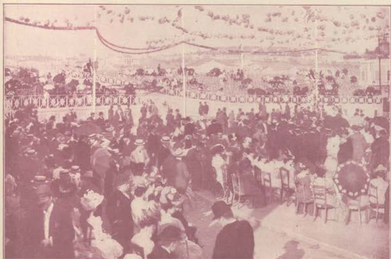
Aspecto da rotunda do Marquês de Pombal—As archibancadas na tarde do dia 14
