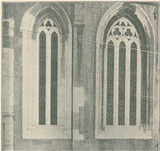
Janellas da capella de Bartholomeu Joannes (segunda maneira da ogiva primaria. Aspecto exterior)
