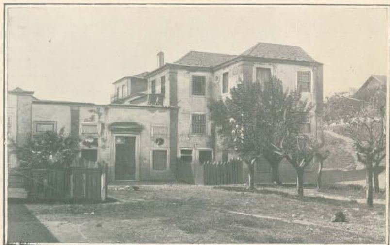
Pateo das Cadeiras — Dependências do primitivo paço da Ajuda, construido depois do terremoto
