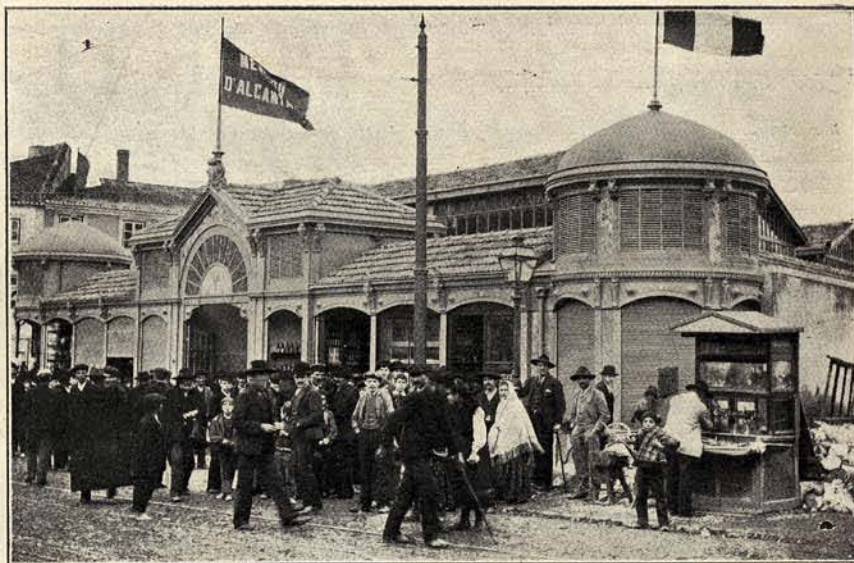
O NOVO MERCADO D'ALCANTARA—A fachada principal
