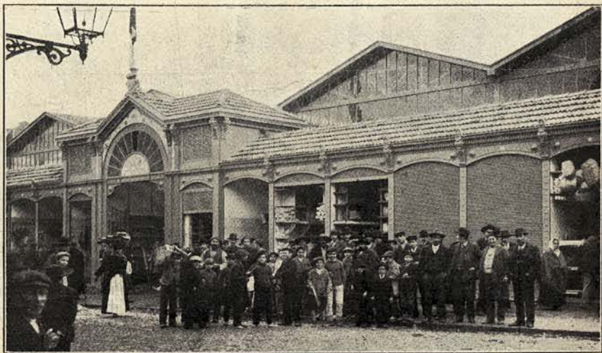
O NOVO MERCADO D'ALCANTARA—A fachada do lado norte
