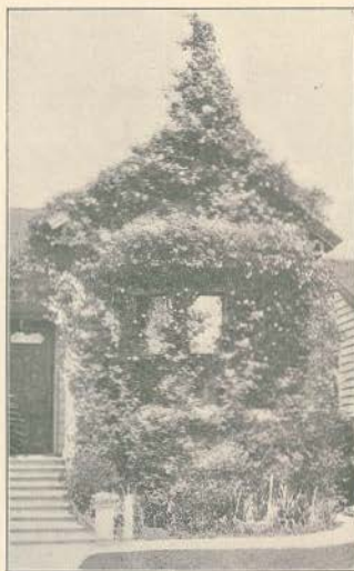
Um «cottage» na California coberto de rosas
