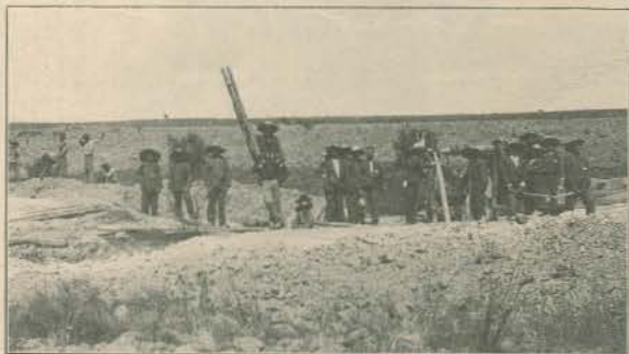
Abertura de um poço
