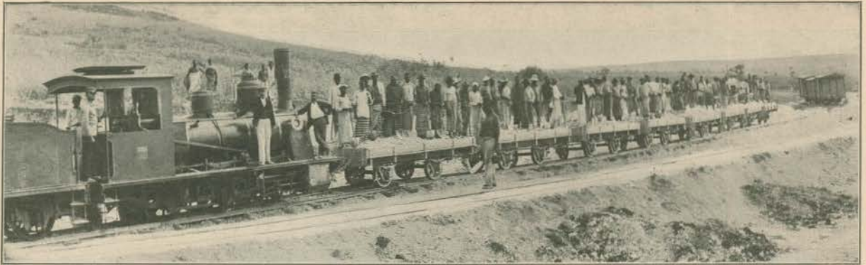
Um comboio de via e'obras no caminho de Loanda a Ambaca conduzindo o pessoal indigena, o conductor europeu e o empreiteiro de todos os trabalhos, sr. Manuel Roberto da Cruz
