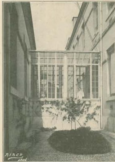
VARANDA DE LIGAÇÃO DOS DOIS CORPOS DO EDIFICIO; DOS LABORATORIOS
